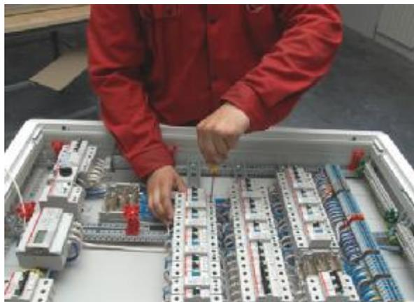
*Справка.* Для обеспечения полной безопасности коммутационная аппаратура устанавливается за защитной передней панелью, при этом снаружи остается только рукоятка управления. Перед началом монтажа вводного аппарата и отходящих устройств – убедитесь в наличии необходимых аксессуаров для монтажа: комплектующих для подключения, монтажных плат и передних панелей, комплектующих для
