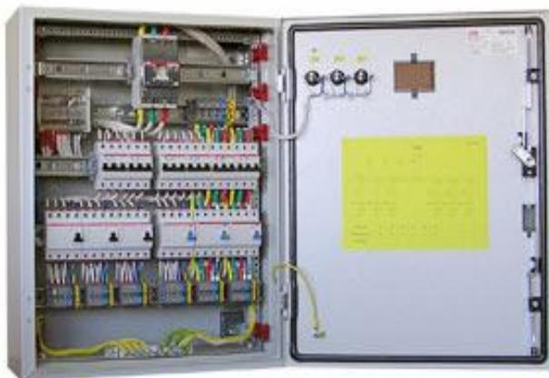
Панель, предназначенная для присоединения противопожарных средств, должна иметь боковые стенки для локализации установленной в ней аппаратуры, а ее фасадная часть должна быть окрашена в **красный цвет** (ГОСТ Р 51732-2001, п. 6.2.30).
