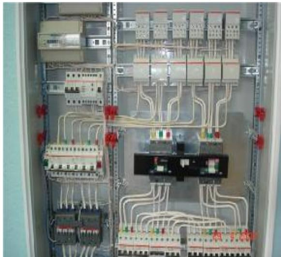
Размеры DIN-рейки (Ш\*Г\*Д): 35 мм.\* 7,5 или 15 мм. \* XXX мм. (стандартная длина DIN-рейки - 6 или 12 однофазных посадочных мест, реже 18 или 24. В соответствии со стандартами, принятыми у отдельных производителей, длины рейки может составлять 175, 215, 260, 300, 600 мм. и т.п. и т.д.). Автоматы отходящих линий подключаются к распределительным шинам или кросс-модулям и соединяются специальной гребенкой.
