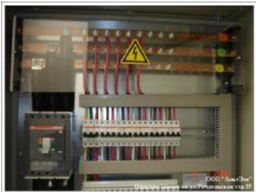
На снимке слева: Вариант монтажа и маркировки силовых шин.
